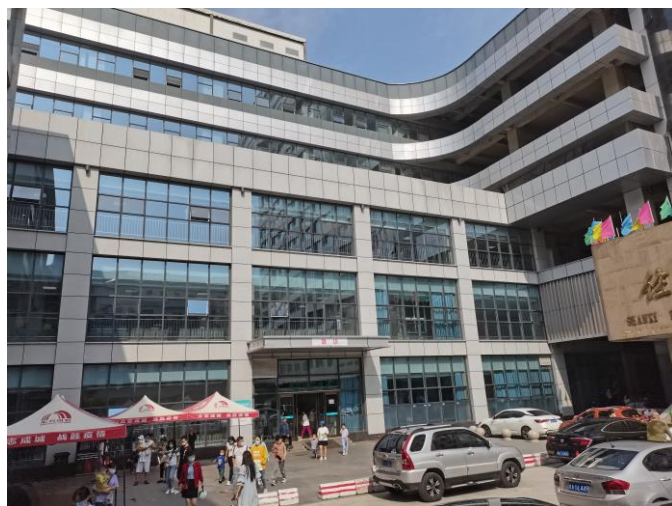
新建门诊综合楼
