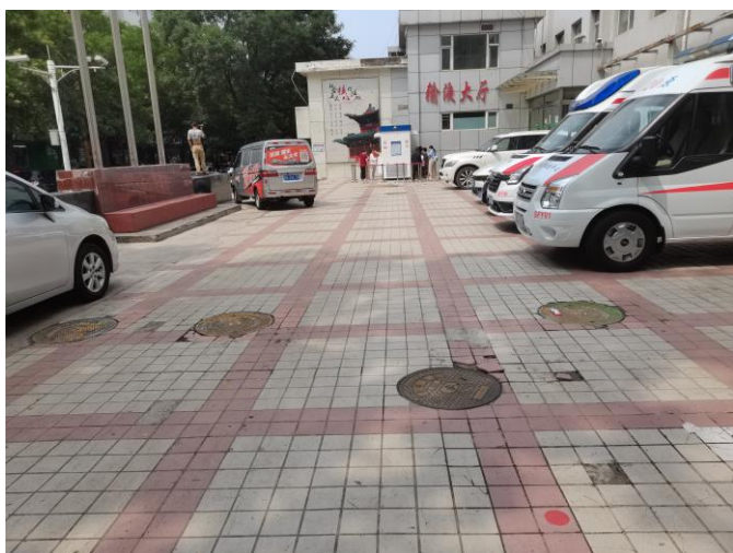
地埋式污水处理站
