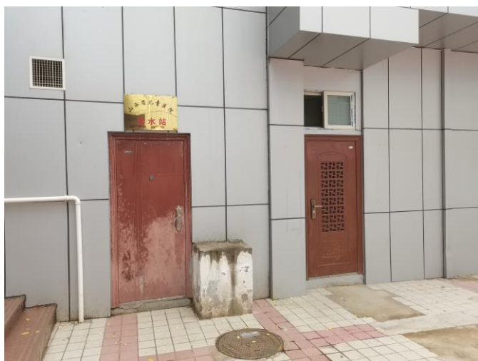
污水站管理房
