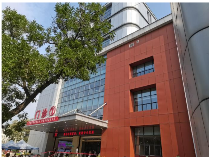
新建门诊综合楼
